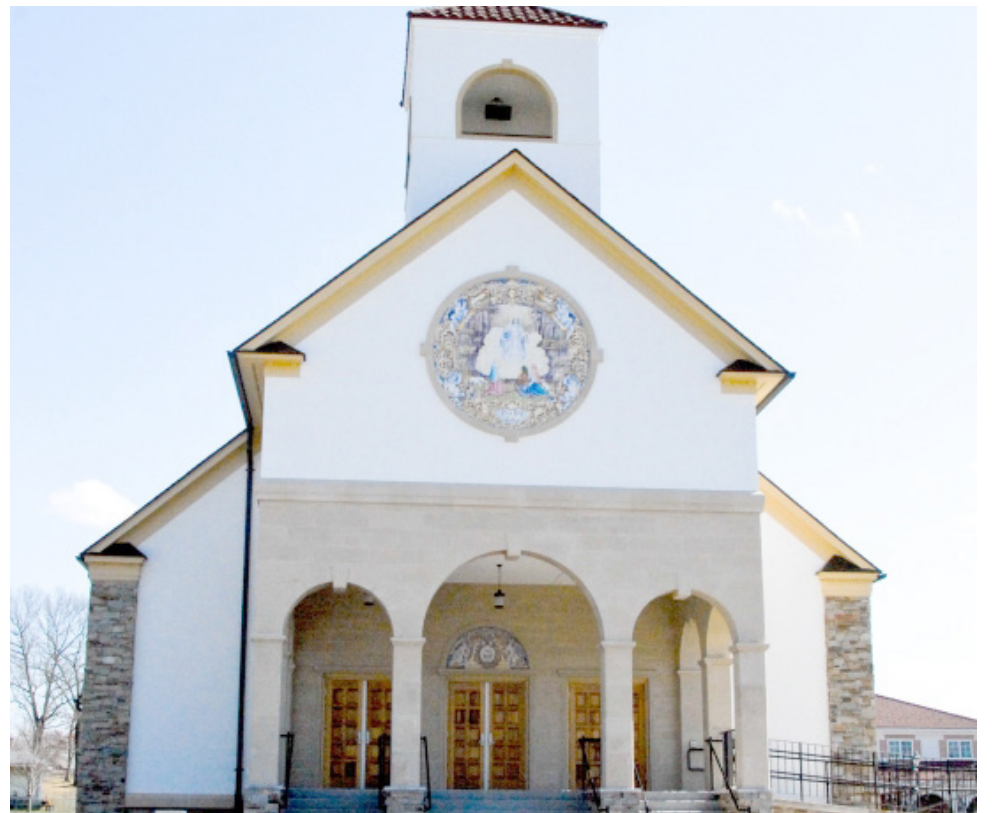
Fachada principal da igreja de Nossa Senhora de Fátima em Ludlow.
